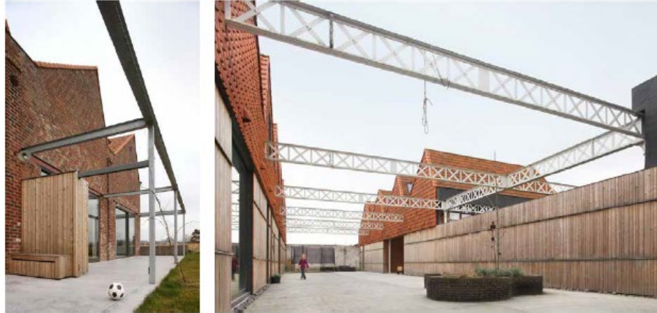
Verbouwing van een textiel fabriek tot een project voor 6 woningen, 1 atelier en 2 kantoorruimtes in Ronse, Volt architecten
